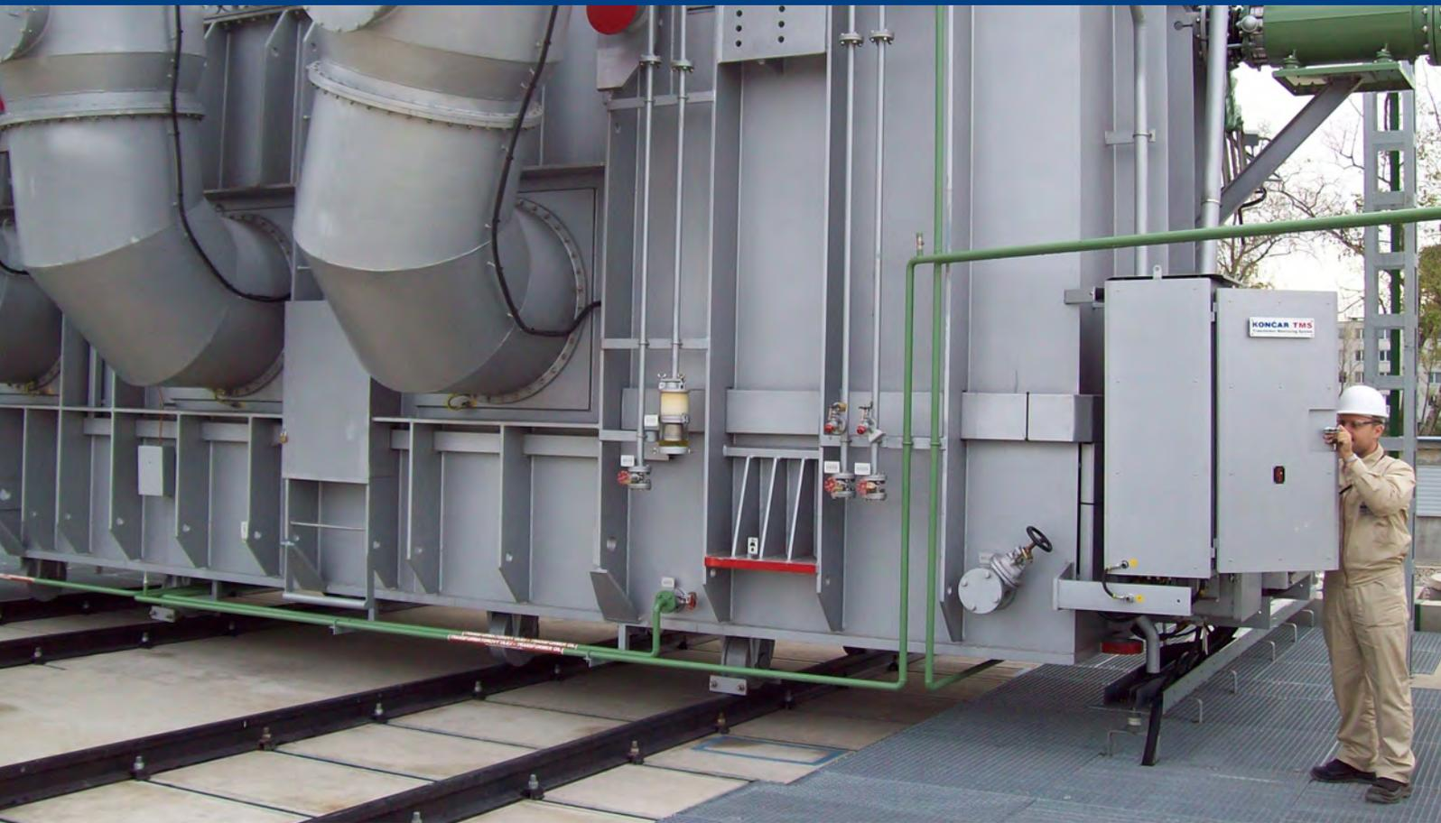
Система мониторинга трансформаторов
