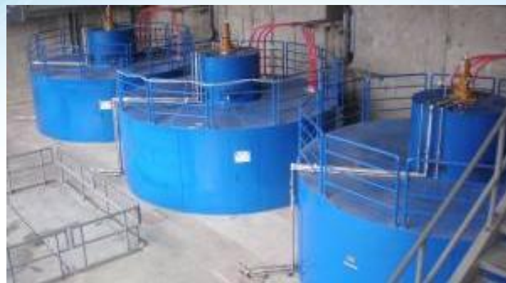
ГЭС МЕГПИ, 3x14 МВА, Канада
