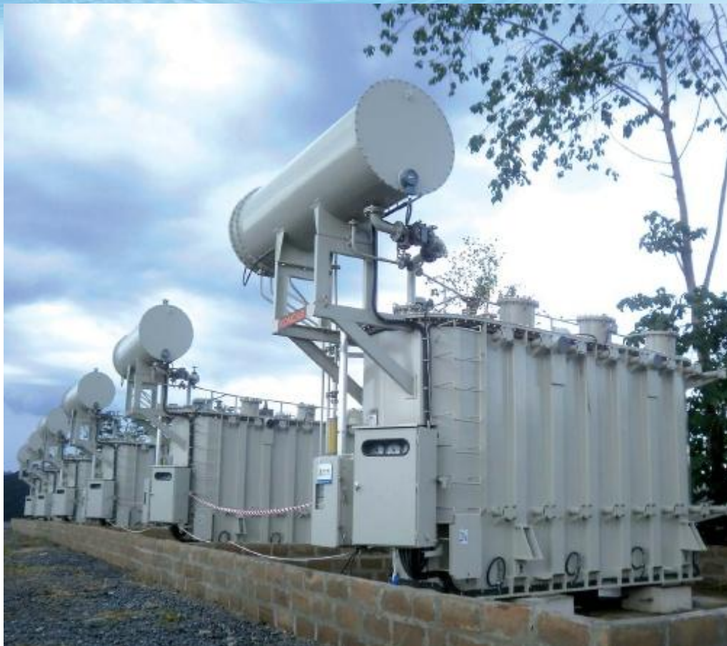
Регулировочный трансформатор 63 МВА, Уганда
