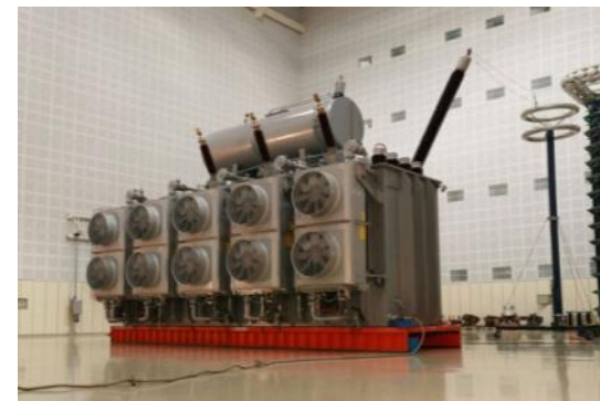
Трехфазный автотрансформатор 350 МВА, Чехия
