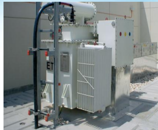
Заземляющий трансформатор 315 МВА,
