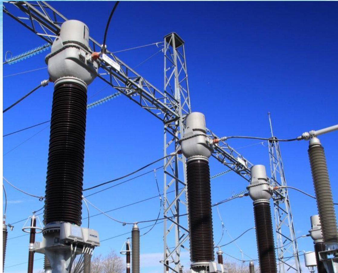
245 кВ комбинированный трансформатор тип VAU-245
