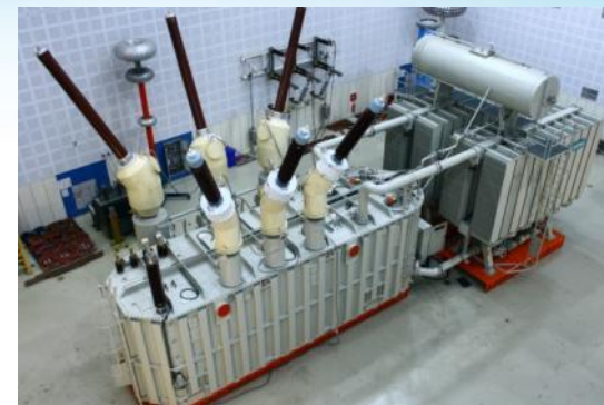
Сетевой автотрансформатор 505 МВА 400/132 кВ, О.А.Э.
