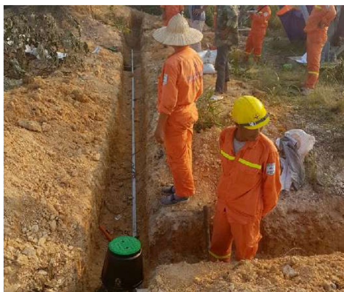
Объект Вьетнамской государственной энергетической компании Vietnam Electricity (EVN)
