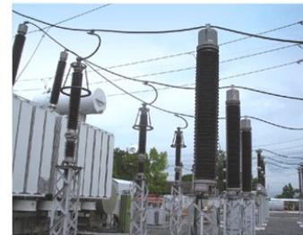
Трансформатор напряжения 245 кВ
